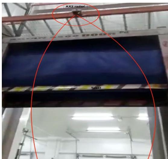
. surveillance de l'arrivée et du départ des camions à une station de quai extérieure de chargement
